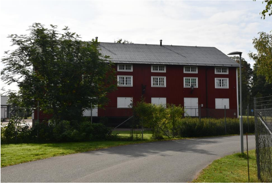
Figur 12 Perspektiv från öst. Kolonnmagasinet sett från Väpnaregatan.
