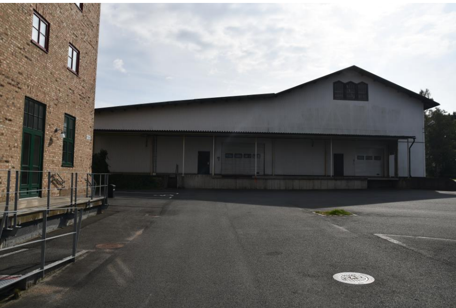
Figur 10 Förrådsmagasinet som ligger bredvid havremagasinet, i nära anslutning till kolonnmagasinet.
