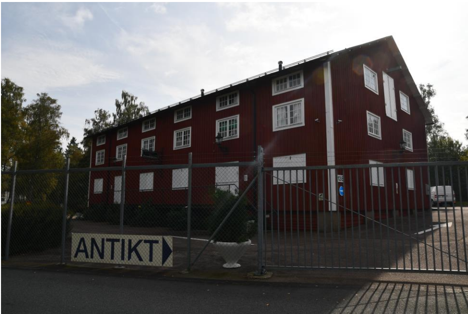
Figur 24 Kolonnmagasinet sett från nordväst.
